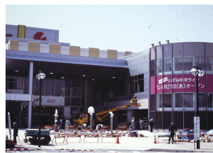
30年前テアトルフォンテ建設中の様子
